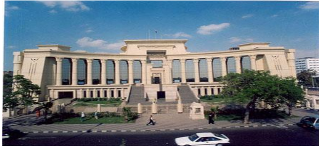
صورة (٥) الواجهة الرئيسية
